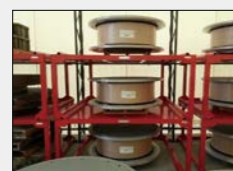
免震ゴム保管
