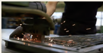
②経験に基づき、1か所1か所丁寧に溶接を 行います。
